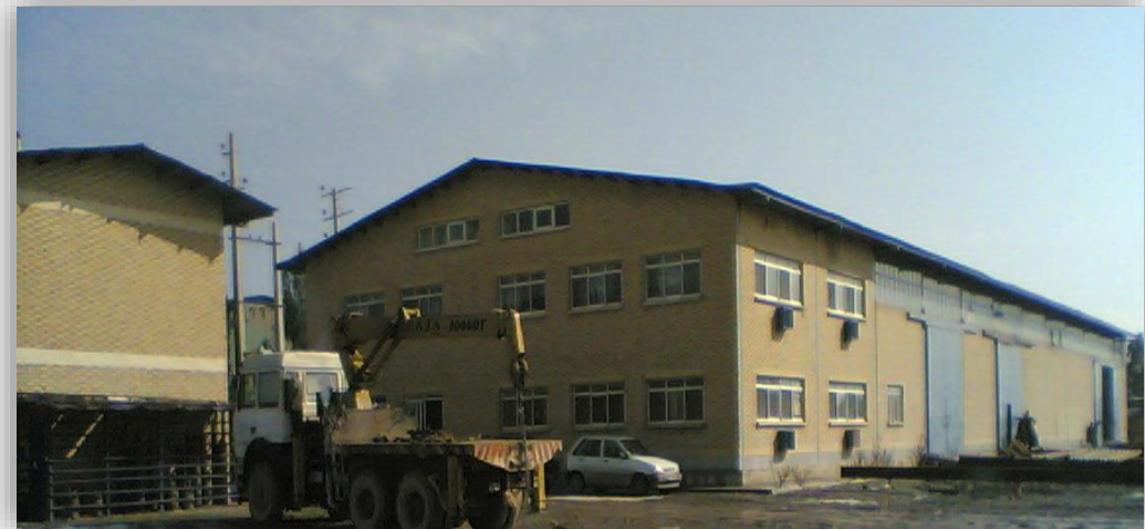
نمای ساختمان ستادی و سالن رنگ ۲
