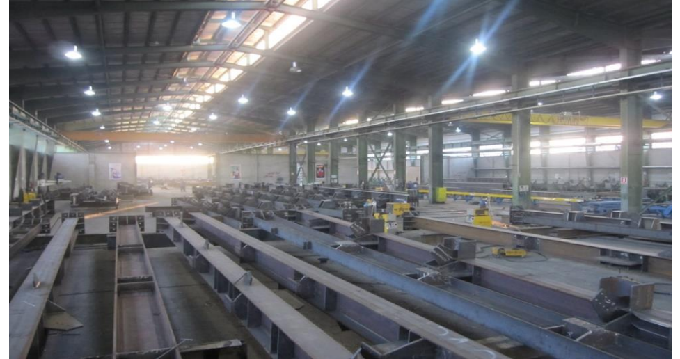
نمای داخل سالن دو قلوئی شماره او ۲ ساخت ، دارای دو دهانه به ابعاد ۱۶۰*۲۵ و ۱۷۶*۲۵ متر
