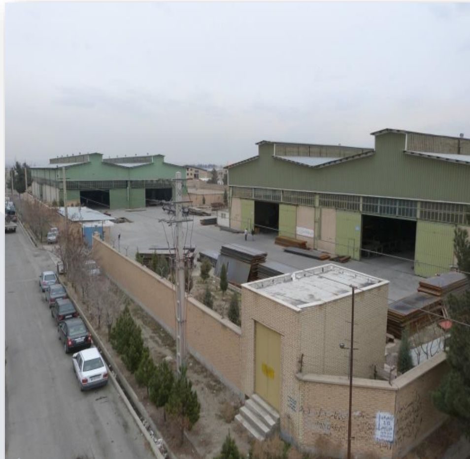
نمای کارخانه شماره ۲ به مساحت تقریبی ۳ هکتار
